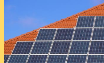
Abbildung 5: Photovoltaikanlage auf einem Dach installiert
