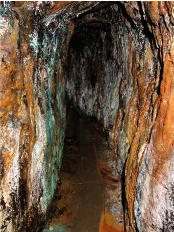
Abb. 5: Im Rathstiefsten Stollen des Rammelsberges. Dieser Stollen wurde um 1150 begonnen. Die Wände sind durch oxidische Metallverbindungen bunt verfärbt
